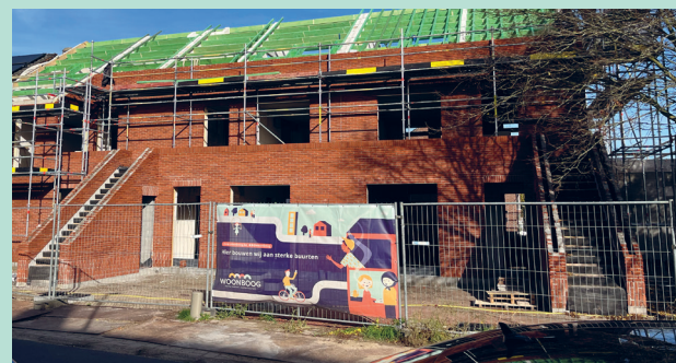
De laatste 6 woningen in opbouw
